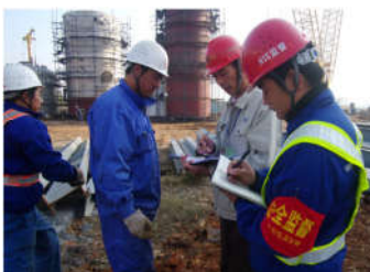
图1 施工现场监管
