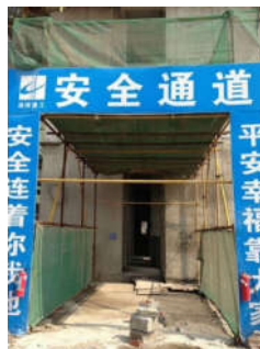
图3 施工现场安全通道
