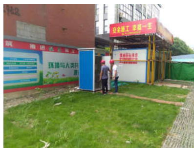
图3 嘉兴市绿色施工示范工程现场
