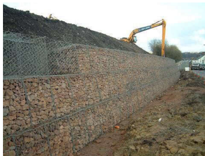
图2 对边坡的护壁方法
