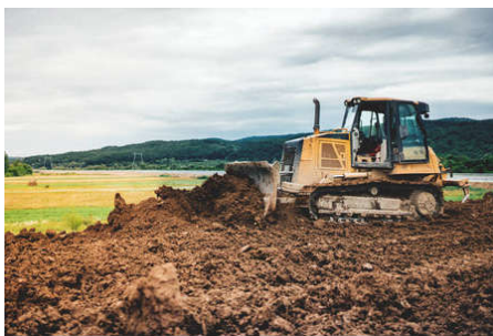
图1 道路压实施工图
