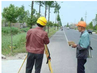
图2 施工人员对道路的测量
