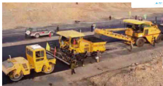
图4 运转车和摊铺机的联合作业
