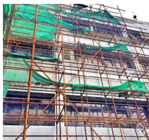
图1 房屋建筑施工现场图
