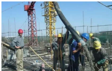
图2 房屋建筑施工监理日常图
