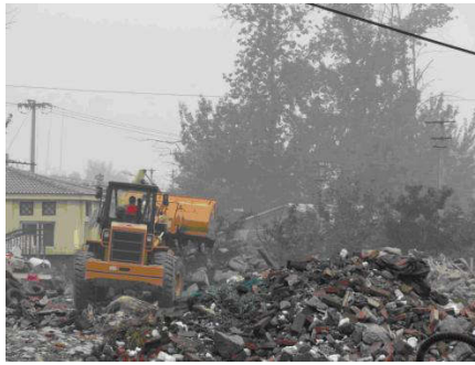
图3 施工污染现场
