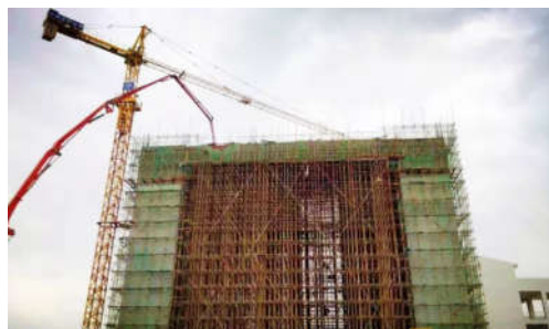
图3 混凝土浇筑施工技术
