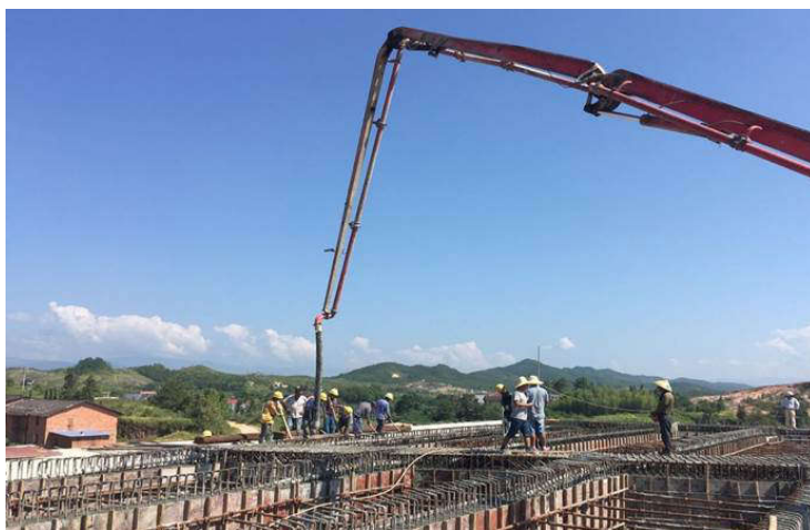
图1 连续梁桥底板浇筑
