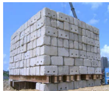
图2 堆载平台荷载检测
