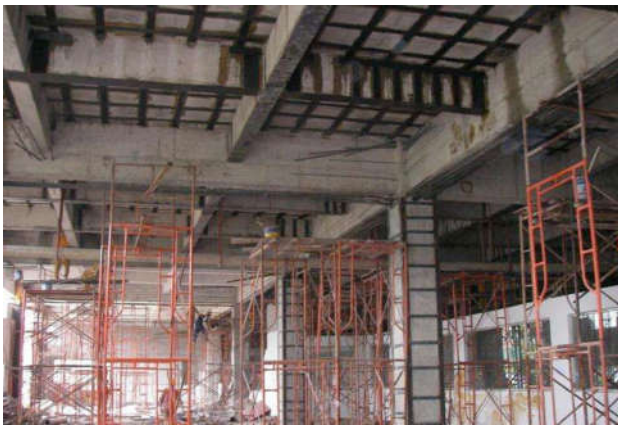
建筑施工中结构加固如图一所示
