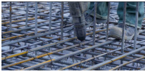
图2 混凝土浇筑前的加固金属框架
