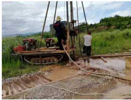
图2 岩土工程勘察现场
