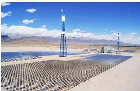
图4 太阳能储能塔
