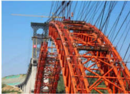
图1 桥拱观测现场
