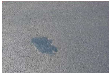
图3 施工现场的沥青胶
