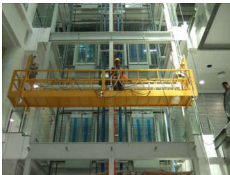
图3 吊篮幕墙装饰施工
