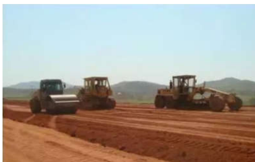
图1 软土路基进行压实处理
