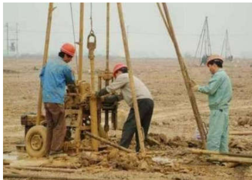
图2 软土路基的地质勘察
