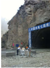
图2 观测施工现场
