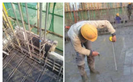
图2 混凝土浇筑施工现场
