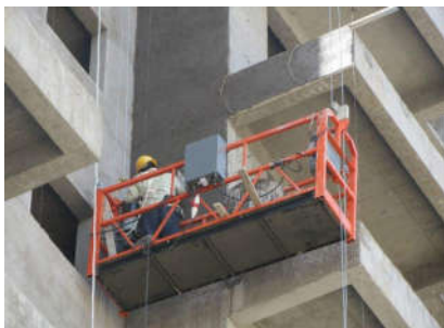
图2 工作中的电动吊篮
