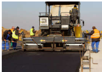
图1 城市中铺设路面图
