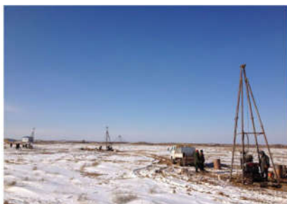
图1 地表岩土工程勘察
