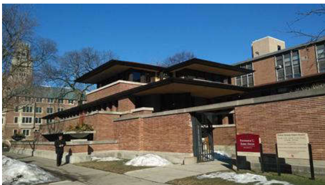
图2 罗宾住宅东南向现场踏勘图
