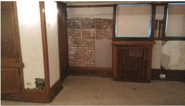
图7 罗宾住宅展示室内维修构造的墙面
