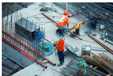
图2 路基路面施工
