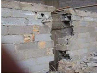
图2 质量不合格的混凝土钢筋结构
