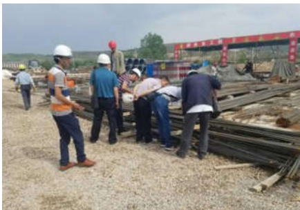
图2 施工现场的材料质量管理
