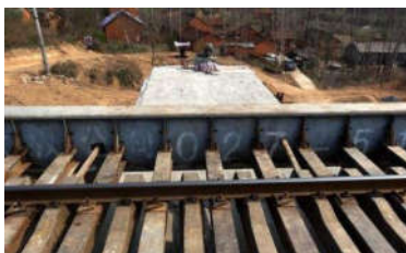
图2 顶进涵施工中的路基加固措施
