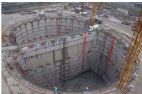
图1 标准的基坑支护施工
