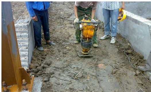
图3 人工夯实施工
