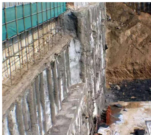
图2 排桩基坑支护
