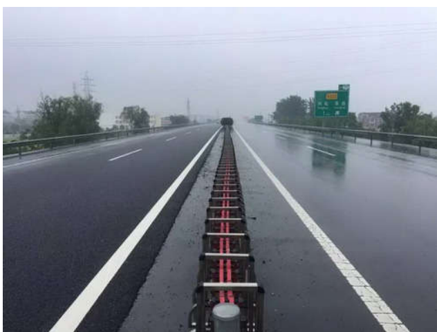
高速公路排水沥青路面如图所示
