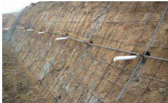
图1 土木工程项目土钉墙边坡支护技术施工现场
