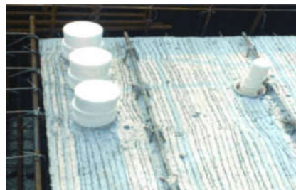
图4 卫生间的管道预埋件
