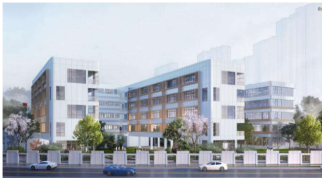
图2 教学楼北侧外窗与设备平台形成综合遮阳系统
