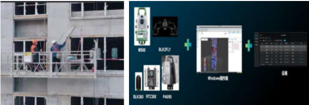
图1 传统外立面检测 图2 三维激光扫描外立面检测
