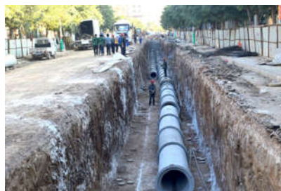
图2 雨污水管道敷设
