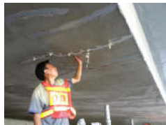
图2 桥面裂缝处理
