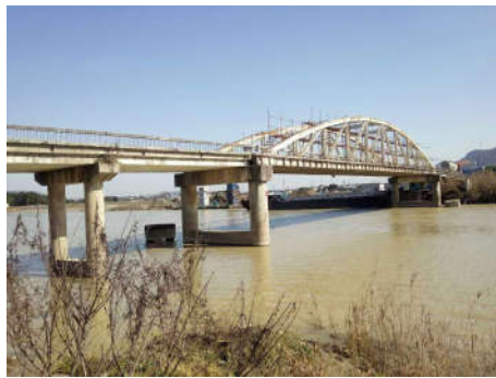
图3 市政桥梁工程
