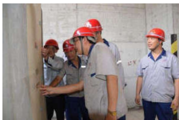
图2 施工环节管理
