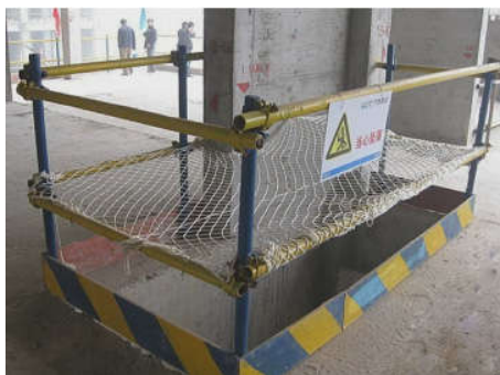
图3 洞口临边防护
