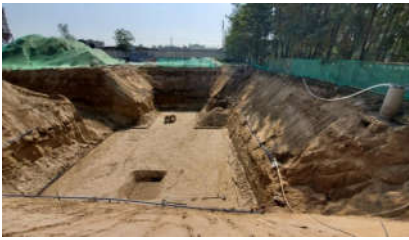
基坑开挖、降水
