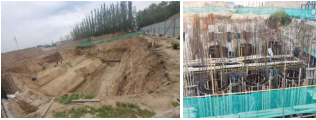
基坑开挖降水及主体施工
