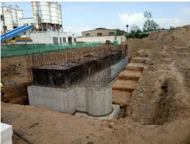
主体工程施工
