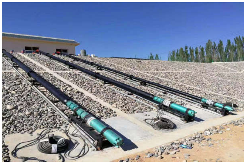
图3 坝体加压取水示意图
