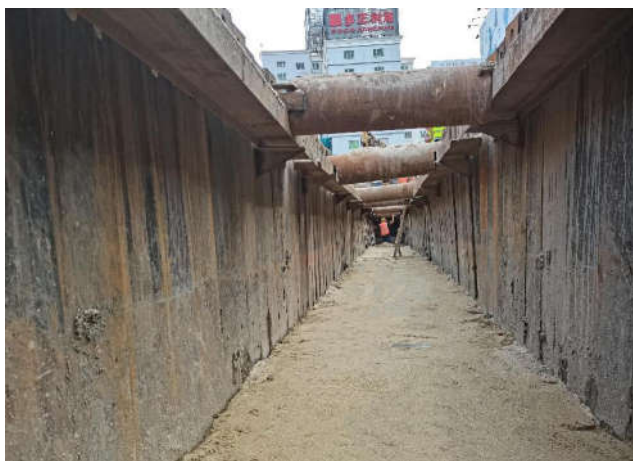
图2 管道垫层施工现场图
