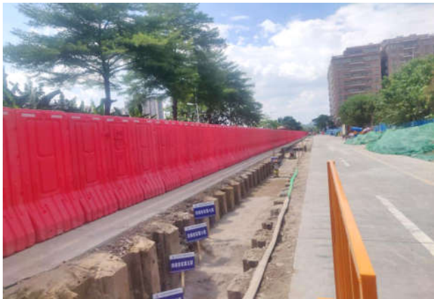
图3 分层回填压实施工现场图
