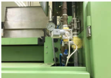
图3 压缩气管路加装电磁阀
