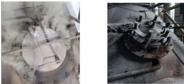
图5 原泄压装置与改进后的泄压装置使用效果对比
