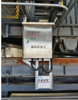
图5 格雷姆线定位安装现场2
