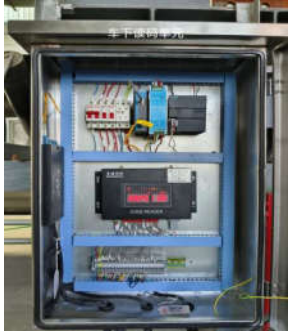
图4 格雷姆线定位安装现场1
