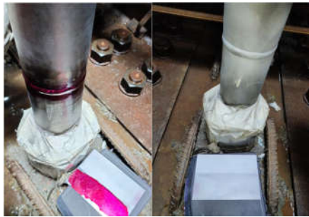
图3 焊接渗透检测
