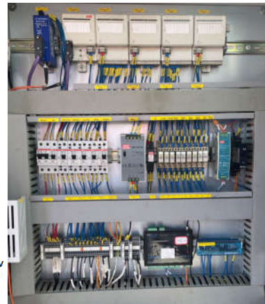
图3 风速仪信号分配控制柜实物布置图
