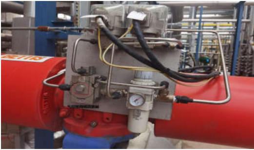
图二 气控换向阀消音器
