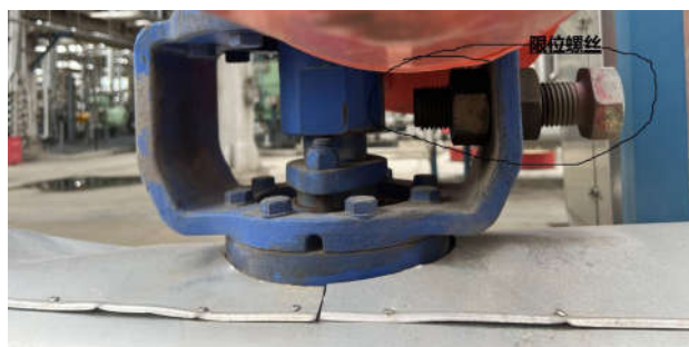
图一 阀门支架增设限位螺丝
