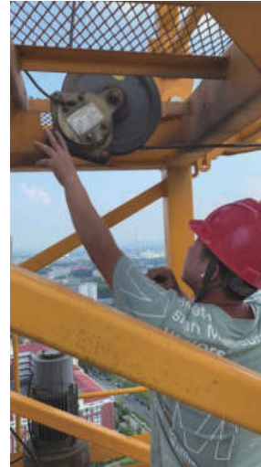
图1 施工器械设备保养
